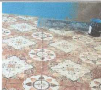
Foto 6: Colocación de piso cerámico
