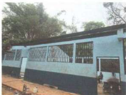
Foto1: Cambio de estructura
