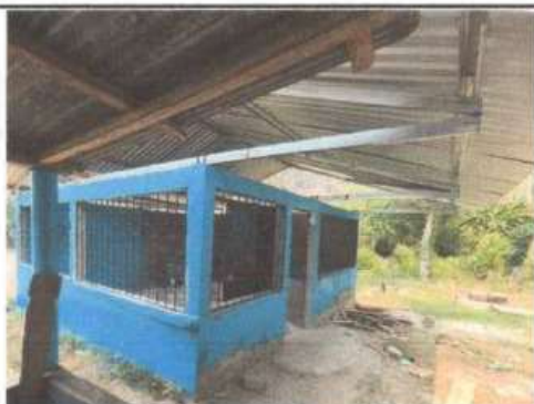
Foto 3: Cambio de estructura metálica
