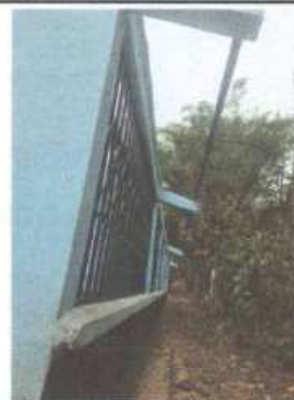
Foto 2: cambio de estructura y entechado
