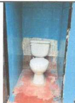
Foto 4: Se observa el cambio de sanitario y pintura
