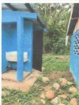
Foto 5: Se observa el lavamanos sustituido
